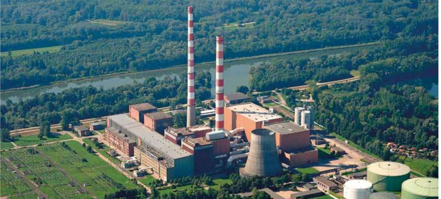
Das Uniper-Kraftwerk in Ingolstadt/Großmehring ist eines der größten Ölkraftwerke Bayerns. Als Brennstoff bei der Stromgewinnung wird schweres Heizöl aus den umliegenden Raffinerien eingesetzt. Das leichte Heizöl wird für die Anfahrprozesse der Kraftwerksblöcke und für die Temperaturstützung des Entstickungsprozesses bei Teillast benötigt. Aufwändige Maßnahmen sorgen für eine umweltschützende Rauchgasreinigung.
