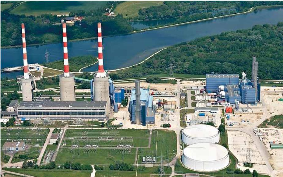
In den Uniper Kraftwerken Ingolstadt und Irsching wird mit Hilfe von Erdgas oder Heizöl Strom erzeugt. Die hochmodernen und sehr effizienten Kraftwerksblöcke Irsching 4 und 5 nutzen die Energie des Erdgases in einem sogenannten Gas- und Dampfturbinen-Prozess (GUD) doppelt. Zuerst werden Gasturbinen, gekoppelt mit einem Generator, angetrieben. Die heißen Abgase werden durch Dampferzeuger geleitet, die jeweils noch eine Dampfturbine antreiben, die ebenfalls auf den zugehörigen Generator wirkt.
