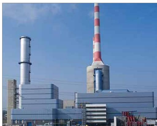
doppelt. Zuerst werden Gasturbinen, gekoppelt mit einem Generator, angetrieben. Die heißen Abgase werden durch Dampferzeuger geleitet, die jeweils noch eine Dampfturbine antreiben, die ebenfalls auf den zugehörigen Generator wirkt.
